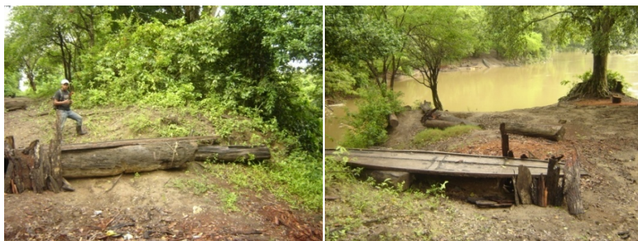
Imagen de la plataforma levantada y del punto de encuentro de los ríos en el lugar.
