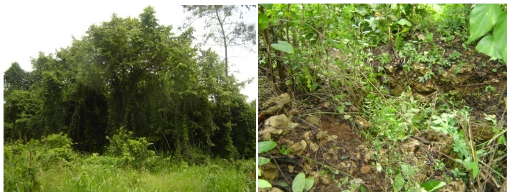
Imagen de la estructura enmontada y de uno de los posos de saqueo.
