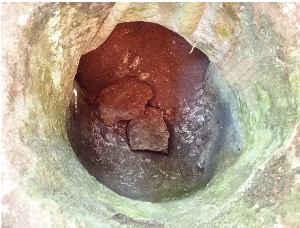
Figura 3.41. Posible piedra de tapa que cayó al interior de la antecámara y se rompió por la mitad.
