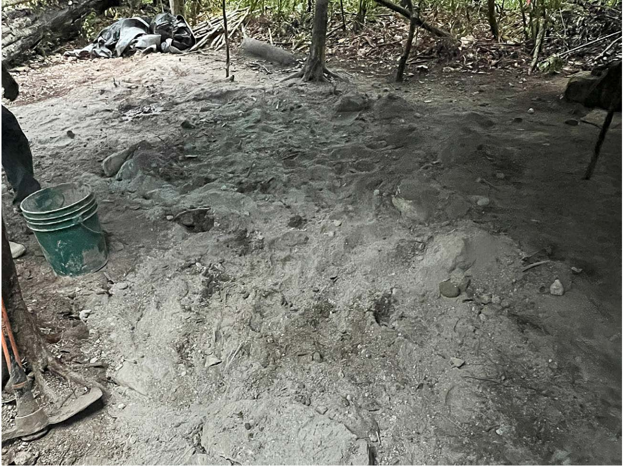
Figura 2.53. Rellenado de la suboperaciones 22A, 22B, 22C y 22D.
