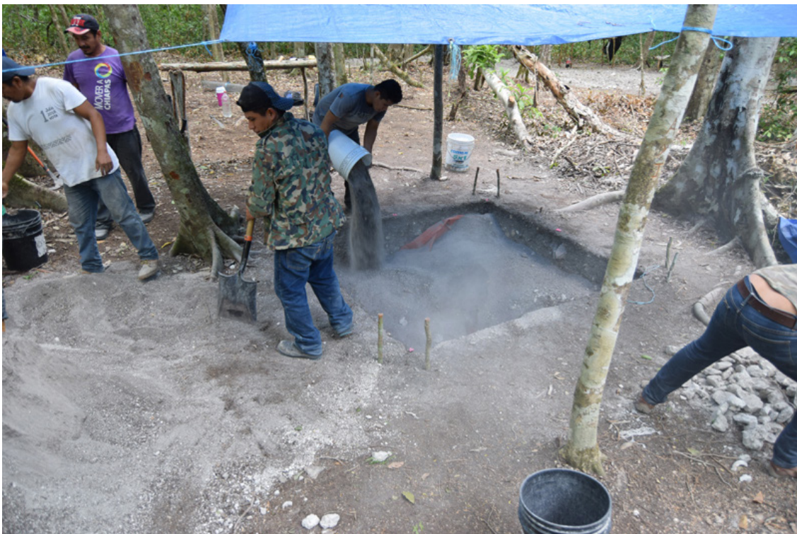
Figura 3.41. Suboperación 18 J en proceso de ser rellenada.
